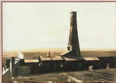
Versuchsanlage mit 22 m hohem Bohrturm auf dem Gelände der IBG in Erkelenz
